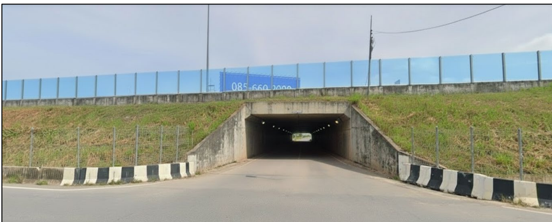
รูปที่ 11-2 รูปแบบเบื้องต้นของทางเชื่อมชุมชนโดยท่อลอดเหลี่ยม
